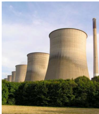
Kühltürme des Kraftwerks Gelsenkirchen-Scholven. Um die Flächenspannung zu minimieren, werden Kühltürme meist in Form (der unteren Hälfte) eines Katenoids gebaut.
