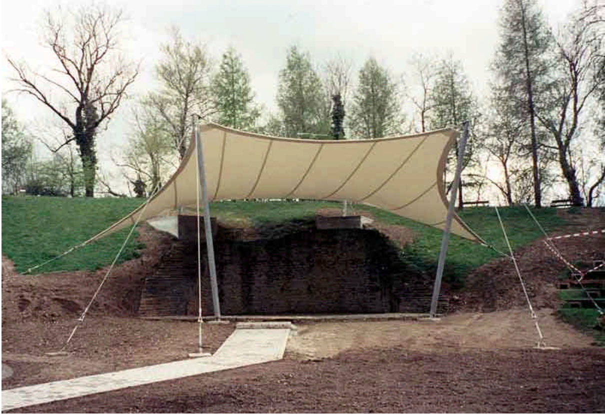
Abb. 5: Sechspunktsegel überdeckt eine kreisrunde Turmuine Ingenieur und Architekt : Tritthardt & Ayrle
