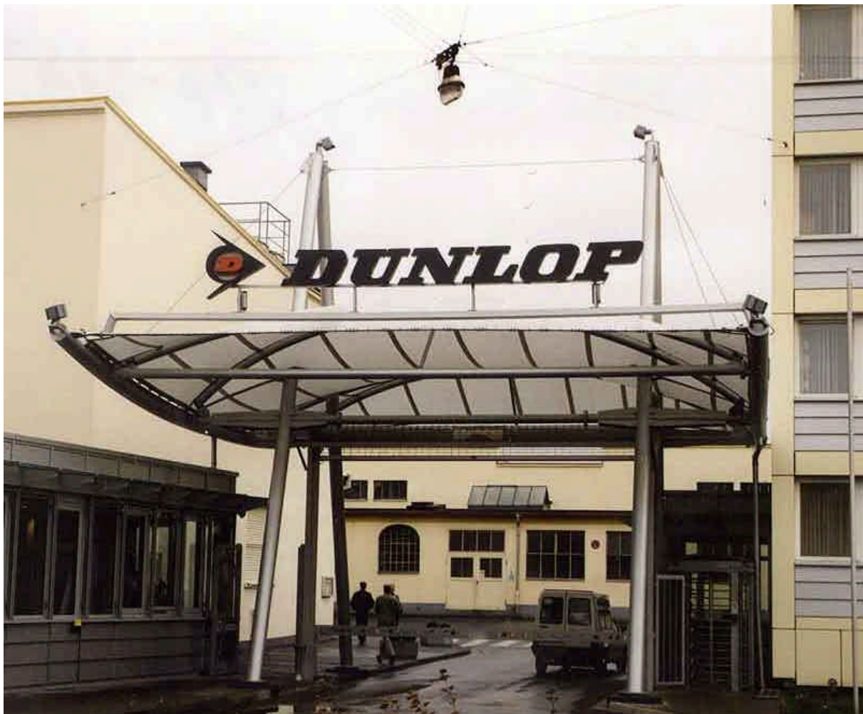
Abb. 8: Gegensinnige Krümmung durch Bögen Ingenieur und Architekt: Tritthardt & Ayrle Designer: Christian Habernoll
