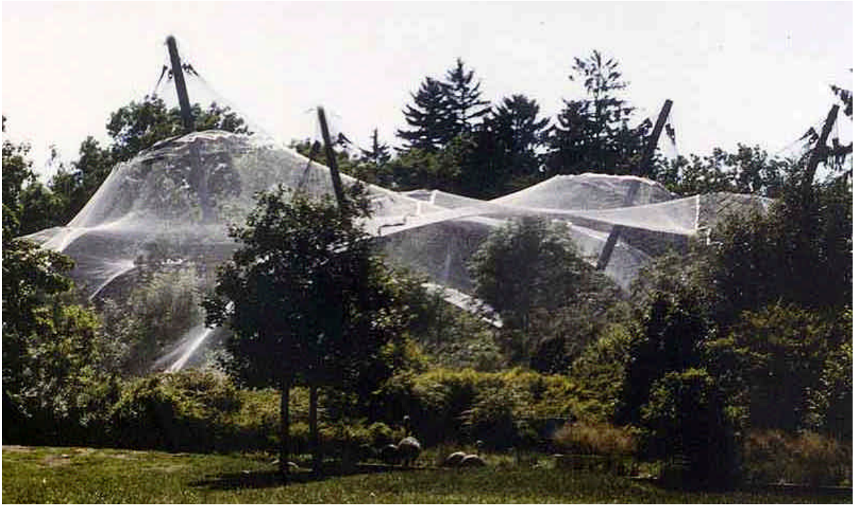
Abb. 6: Das Beispiel einer Voliere zeigt die Loslösung der Dachform von geometrischen Grundfiguren
