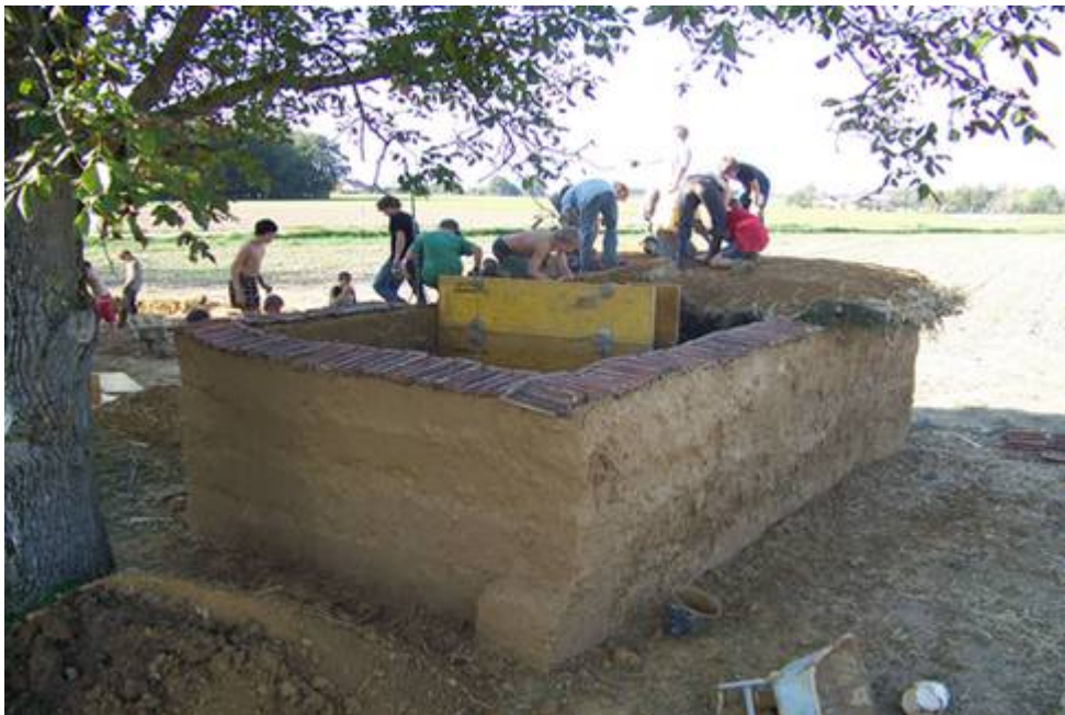
Lehmbauprojekt in Uttendorf/OÖ, Klasse 4c Gymnasium der Herz Jesu Missionare
